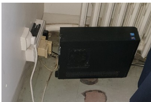
Poste informatique – Prise RJ45 et prises gigogne
